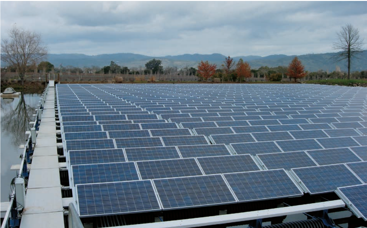
FIGURA 7.1 » Instalação fotovoltaica flutuante sobre uma lagoa de irrigação na região do Vale de Napa, Califórnia (EUA); entre as vantagens proferidas por desenvolvedores desse sistema estão a ausência de obstáculos, a melhor eficiência devido à temperatura próxima à lâmina d’água, a redução da evaporação e a redução do crescimento de algas e outros organismos (devido à redução da temperatura).
