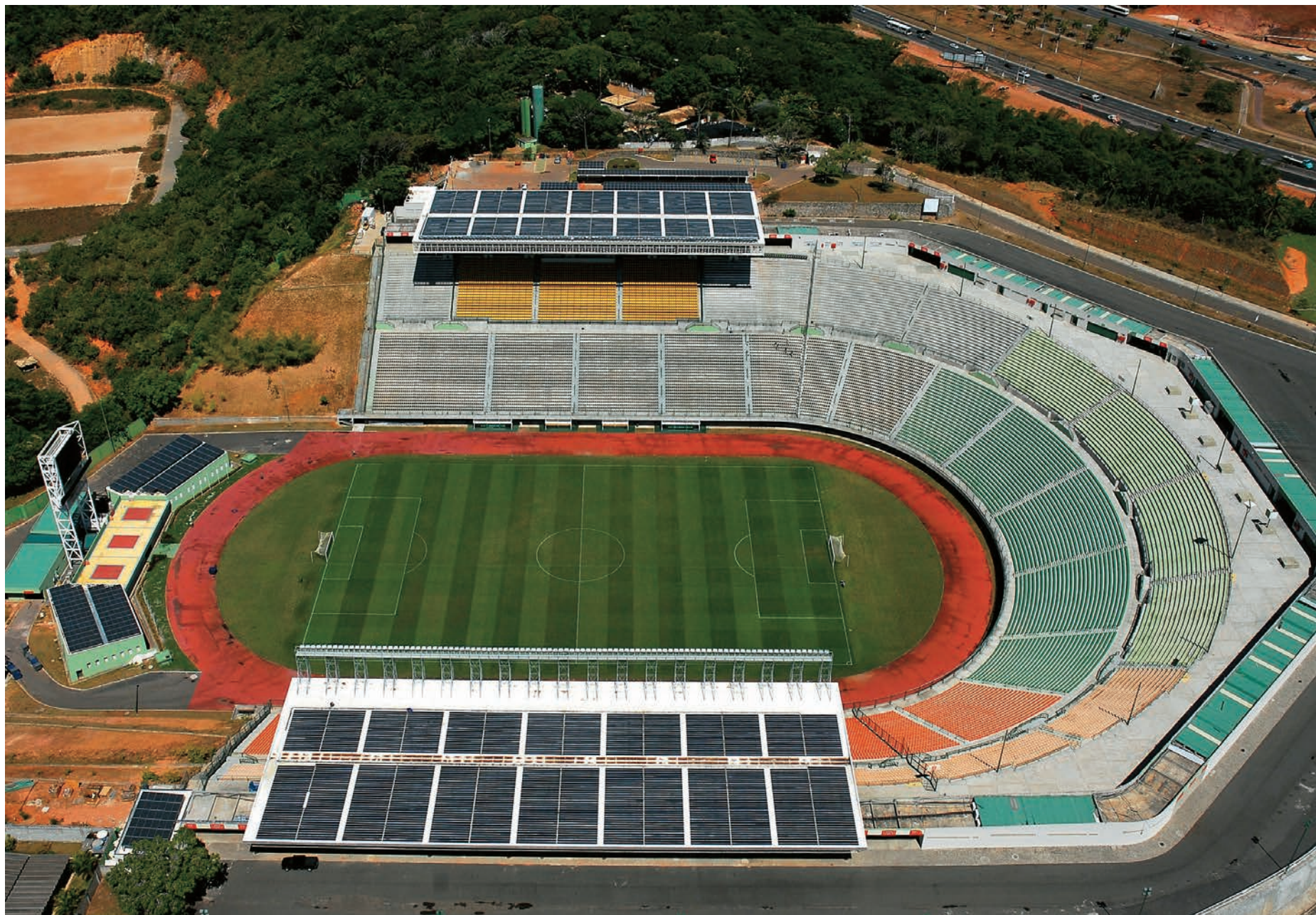
FIGURA 4.7 » Usina Solar do Estádio de Pituaçu, com capacidade instalada de 404 kW e composta por 2.292 módulos fotovoltaicos.
