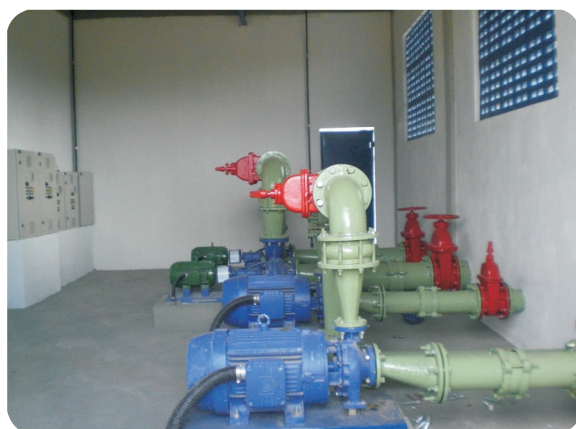
Barriletes de Água Tratada da Elevatória
