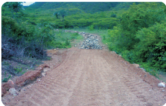
Estrada e construção de passagem molhada
