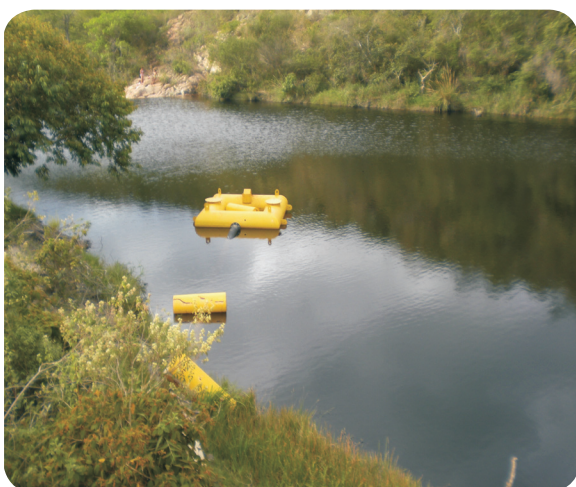
Captação de Água Bruta
