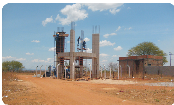
Construção do RED – 200m³
