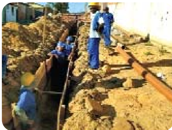
Rio de Contas – Assentamento de Rede Coletora
